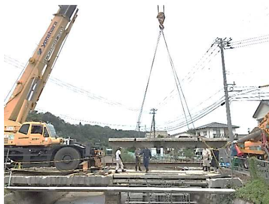
《撤去状況(H28.10月)》
